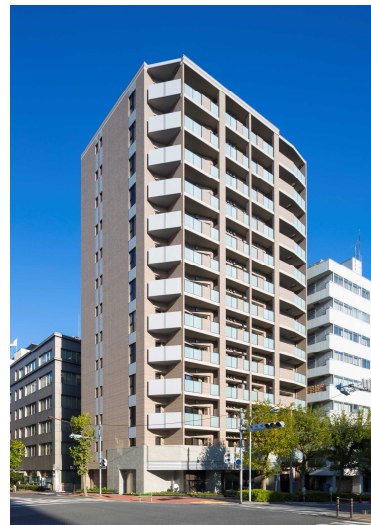
ザ・パークハウス東銀座新築工事
