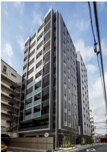
(仮称) 国分寺市南町 3 丁目計画新築工事 (物件名：ザ・パークハウス国分寺プレイス)
