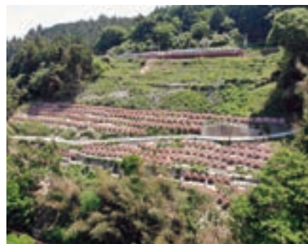
上古沢地区緊急地すべり対策工事
