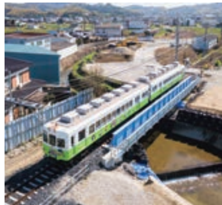
貴志川線 吉札～伊太祈曾間 河道拡幅に伴う平尾第一橋梁架替工事
