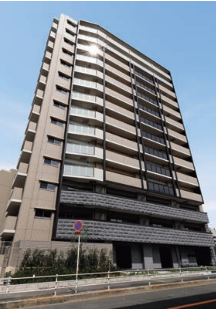
物件名—プレサンスロジエ四條畷忍ヶ丘ザ・テラス 所在地—大阪府四條畷市
