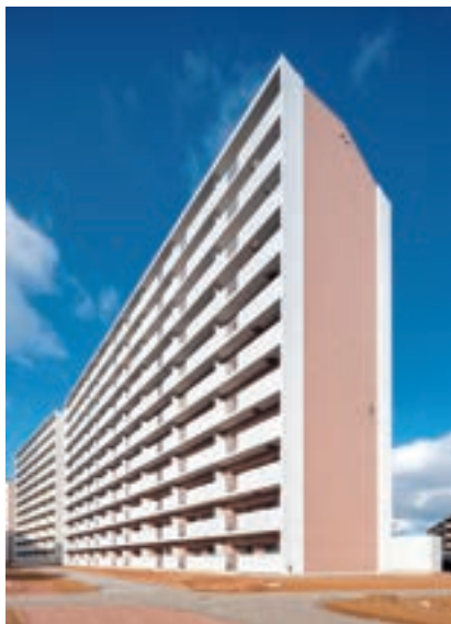
大阪府宮堺三原台住宅 7棟
