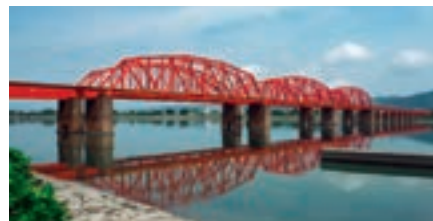
南海本線 紀ノ川橋梁下り線低水敷き 橋梁塗装工事
