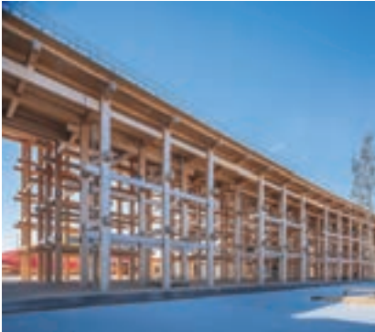
2025日本国際博覧会協会 施設整備事業 PW西工区(建設工事)
