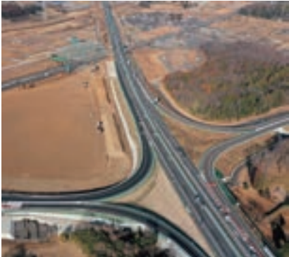
首都圏中央連絡自動車道つくばスマートIC工事
